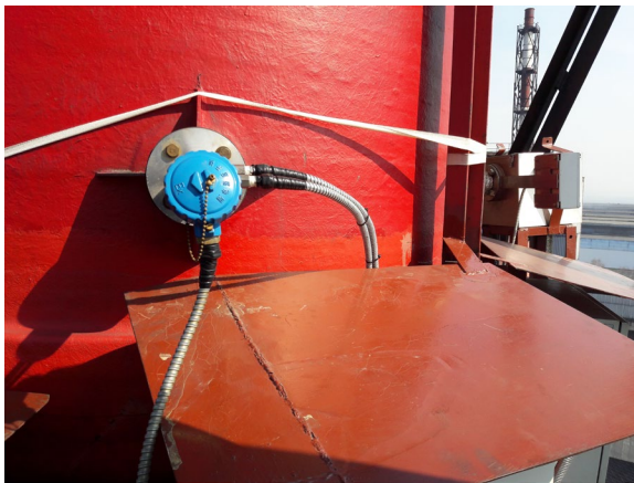
Модуль TPF-100 для измерения параметров потока
